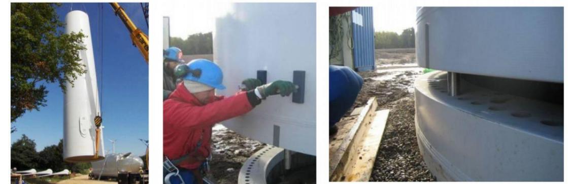
Les sections de tour suivantes sont ensuite assemblées. L'assemblage de la section haute et de la nacelle est planifié le même jour.
